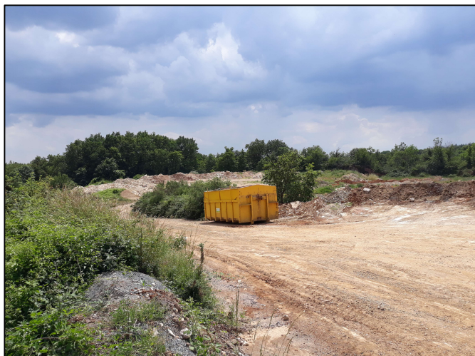
Photo 10.: Vue sur la benne mise en place pour récupérer les déchets qui ne seront pas stockés.
